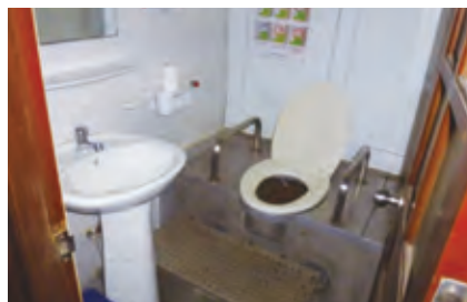
観光船内に設置したバイオトイレ(SW-43型)
