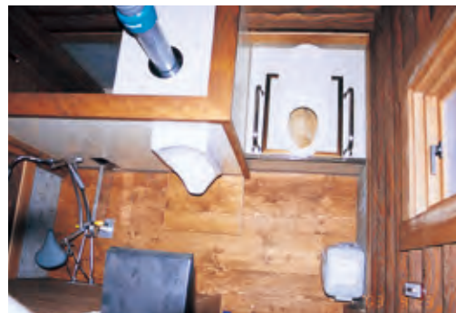
■人力により処理層を攪拌するペダルタイプ 小便器よりオシッコのみを外部へ出す個液分離も可能です。
