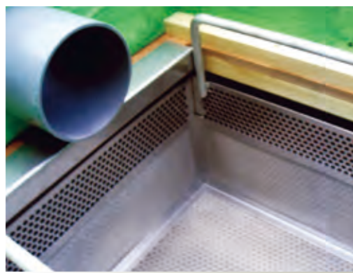
■流入口(台所等から流れ出た生ゴミを除去するカゴ)
