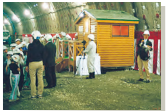
■赤岩トンネル工事現場
