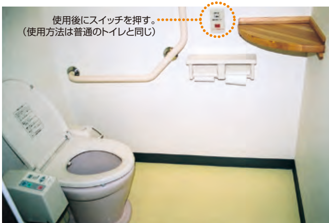
■会社事務所・家庭用トイレ(洗浄便座使用)
