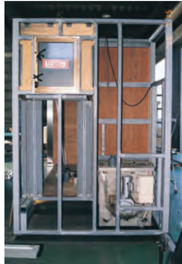
壁には断熱材が入っていますので室内はあたたか
