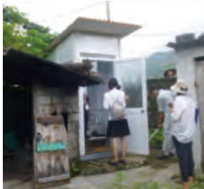
個人宅に設置されたバイオトイレ
