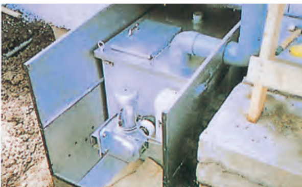
汲み取り式をバイオトイレに入替工事中です。ステンレスピットの中に本体を入れます。
